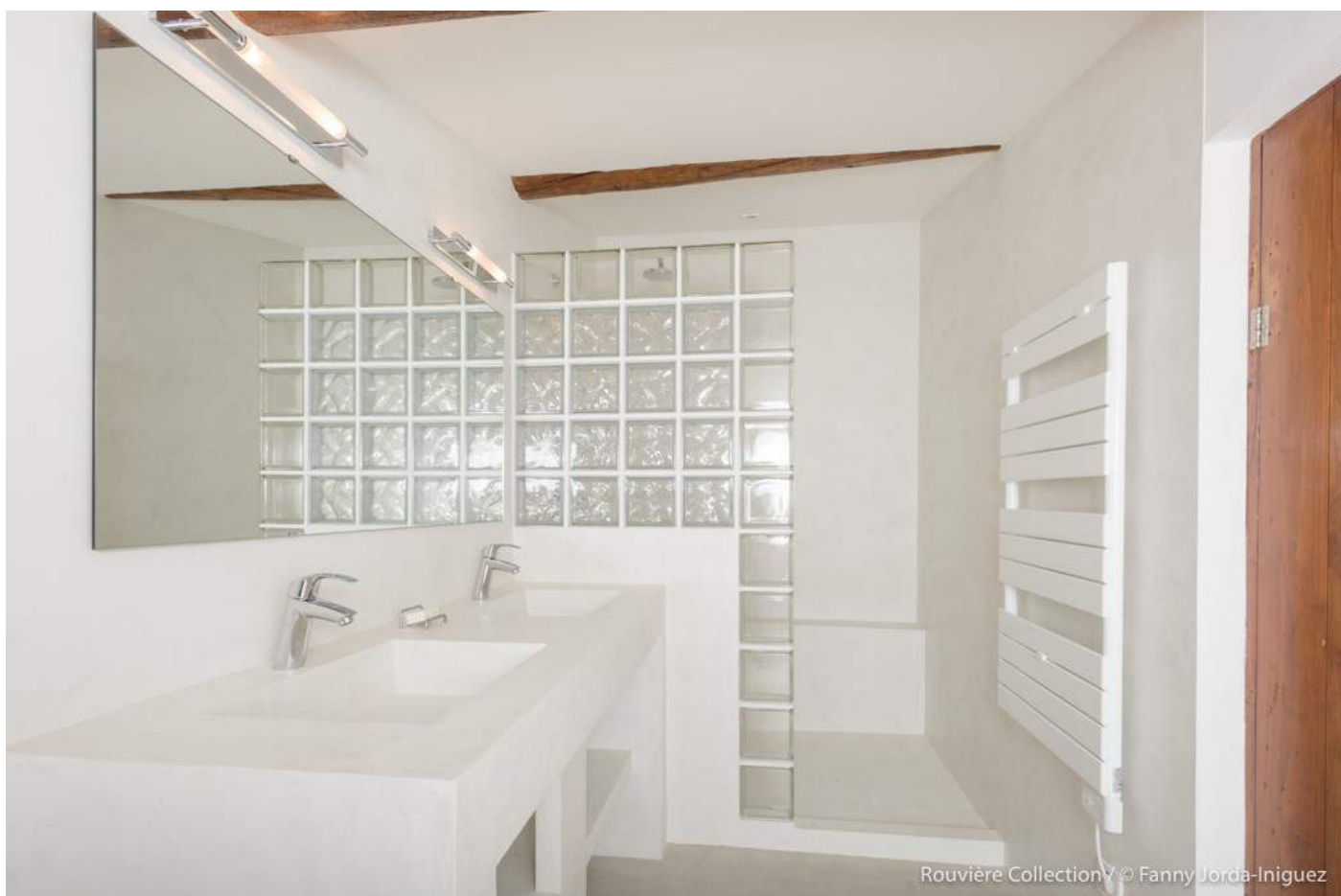
En haut salle d'eau entièrement revêtue de micro-béton dans différents tons de Ocre; en bas, salle de bains complète en béton ciré blanc : mobilier, sol, murs et douche à l'italienne
