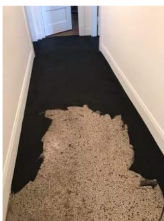
Ci-dessous : exemples de rénovations de sols en carrelages avec application directe de micro-béton (Decostyles—57)
