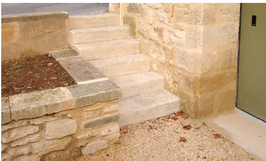
A gauche : Marches massives aspect vieilli. Ci-dessous : Pièces en L sur mesure Réalisations Rouviere Construction
