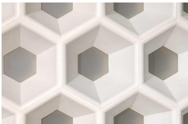
Réalisation de blocs de façade hexagonaux avec une face alvéolée et l'autre lisse. Deux blocs de béton enfermant une brique de verre neutre satinée en leur centre. Conception Rundedell Associates. Réalisation et pose Rouviere Collection
