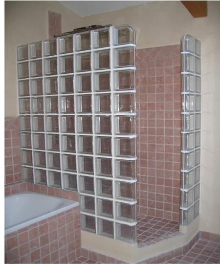
Douche en brique neutre lisse transparent, finition avec les briques terminales simples et doubles
