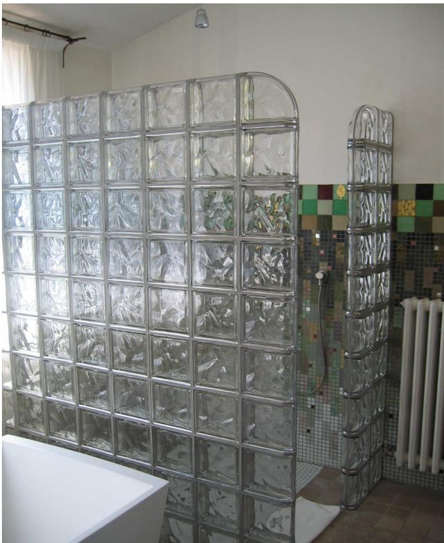
Parois de douche en briques de verre argenté ondulé finition avec les briques terminales simples et doubles
