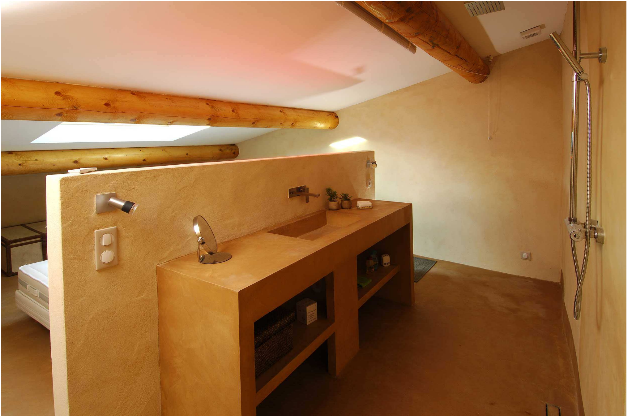
douche et mobiliers en microbéton
